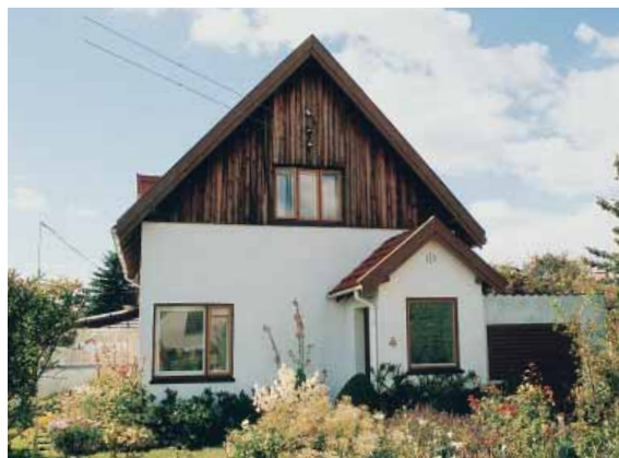
Ejstrupvej 4. Huset har fået ny tagkonstruktion i forbindelse med udnyttelsen af tagetagen. Endvidere er der sket yderligere knopskydninger.
