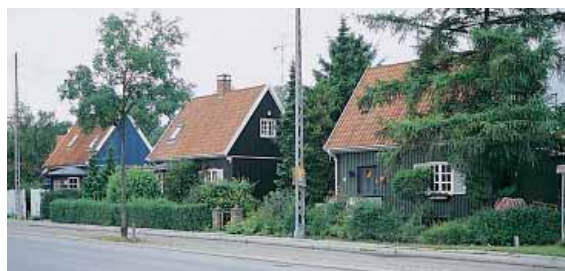
Phønixhusene langs Brostykkevej er eksempler på tidlige typehuse fra begyndelsen af 1920'erne. Husene er oprindelig alle opført i træ. Næsten alle husene er om- eller tilbyggede.
