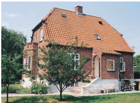
I.G. Smiths Allé 39, opført 1932. Bemærk det fint detaljerede indgangsparti.
