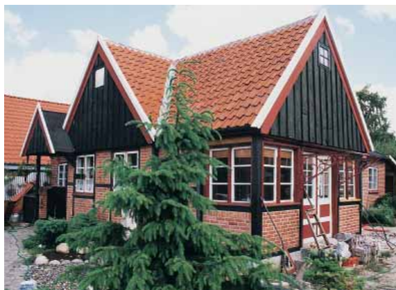
Lerbjergvej 26. Husets mange udvidelser er holdt inden for samme størrelsesorden og udtryk som den oprindelige bygning.
