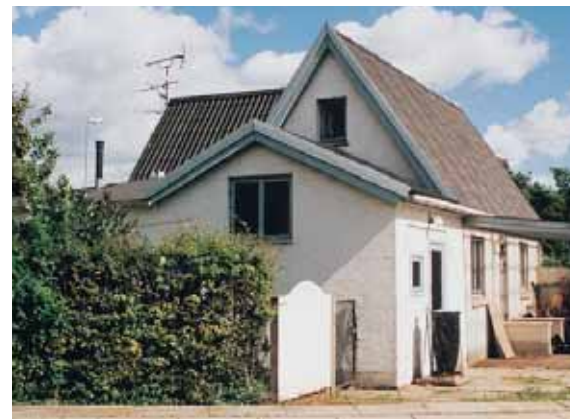
Ejstrupvej 15. Huset har undergået gradvise bygningsudvidelser, hvor de forskellige tilbyggede bygningsafsnit er aftrappet i forhold til den oprindelige bygning.
