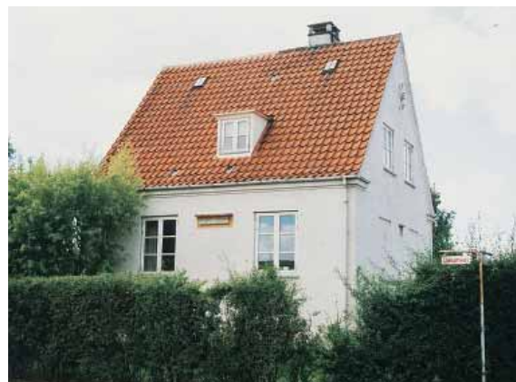
Kløvborgvej 1, opført 1930. Vederlagsgesimsene i gavlene er typiske for disse traditionelle huse. Kendetegnene for bygningerne er også de mange, fint bearbejdede håndværksmæssige detaljer.
