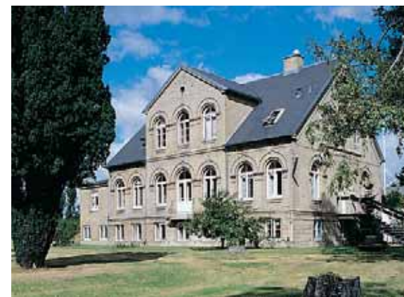
Kastanienborg, opført omkring 1900, med mange detaljer og udsmykning i murværket.
