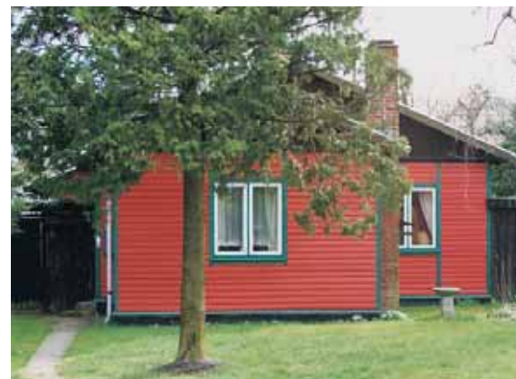
Vojensvej 27. Husets gradvise udbygninger er holdt i samme materialer som den oprindelige bygning, men med et mere forenklet udtryk.
