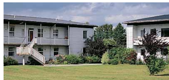
Strandhavevej-bebyggelsen har et let og enkelt udtryk i en god og menneskelig skala, hvor de integrerede udearealer byder på lys og luft til beboerne.
