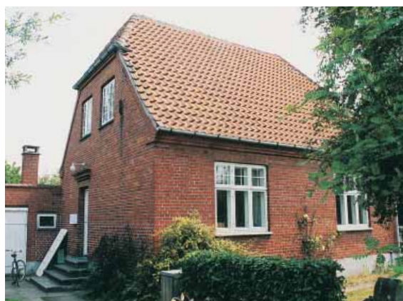
Krogstens Allé 9 Traditionelt velproportioneret murermeisterhus fra Bedre Byggeskikperioden. Huset er ret anonymt, men har god originalitet med flere bevarede bygningsdetaljer som f.eks. gesims, trappe og vinduer. Dog mangler skorstenspiben. Bevaringsværdi 4.
