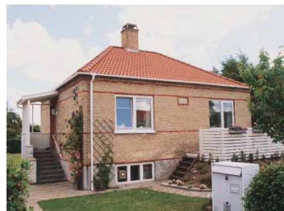
Lerbjergvej 14 Traditionel bungalow med gode proportioner og enkle facader. Udskiftede vinduer og nye tagsten er ikke i overensstemmelse med husets oprindelige materialevalg. Ændringerne forandrer dog ikke bygningens hovedudtryk væsentligt. Bevaringsværdi 5.
