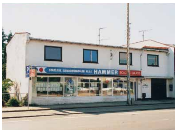
Hvidovrevej 108 Et stærkt ombygget hus, der i forvejen ikke har stor arkitektonisk værdi. Butiksfacaden er disharmonisk og uden sammenhæng med 1. salens vinduestakt. Huset har dog en vis værdi, som en del af gadeflugten. Bevaringsværdi 7.
