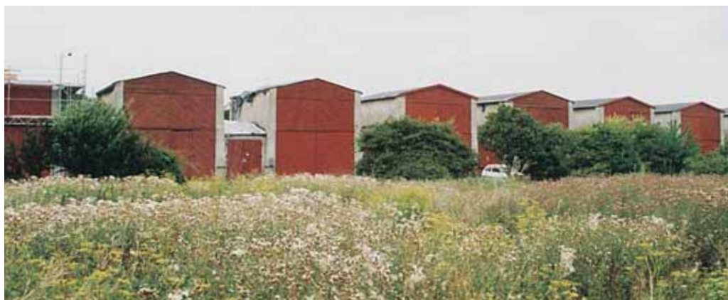
Avedøre Flyveplads med fredede motorprøvestande fra 1943.
