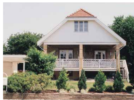
Krogstens Allé 29 Oprindelig en stram funktionalistisk bygning, som nu er stærkt ombygget. Ombygningerne modarbejder og ændrer afgørende husets oprindelige udtryk, bl.a. ved den halvvalmede gavl og det store tagudhæng. Bevaringsværdi 8.
