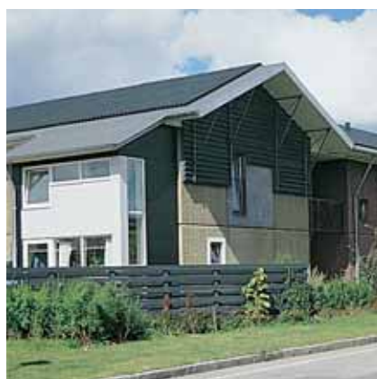
Den påbegyndte ombygning af gårdhavehusenes flade tage til sadeltage er udført på en bevidst og regulær måde således, at husene ikke afgørende ændrer karakter.
