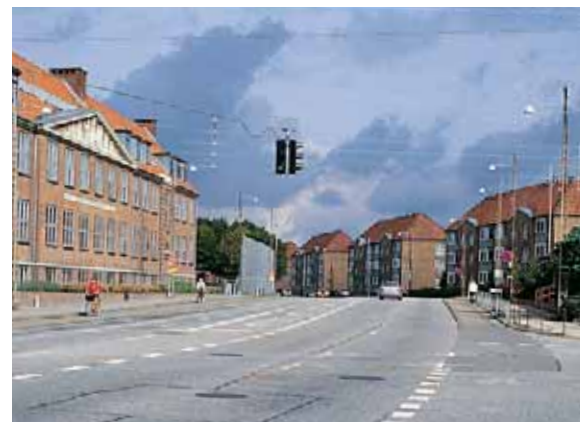
Hvidovrevej syd for Holbækmotorvejen præges af Sønderkærskolen (til venstre) og Spurvegården (til højre).
